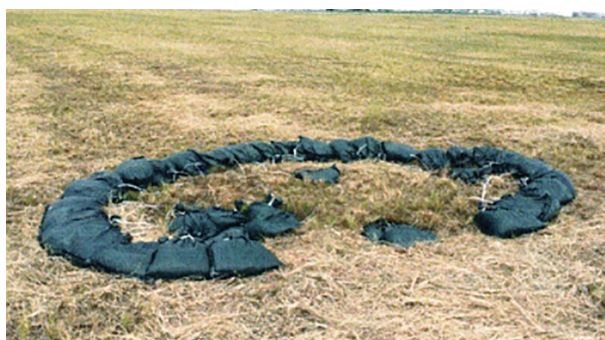
着陸帯の陥没写真
